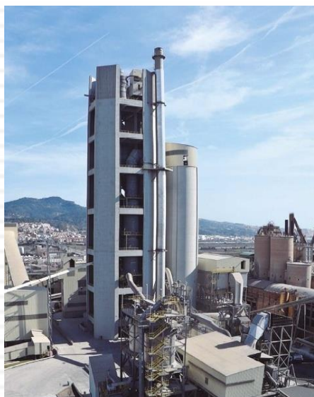
Fábrica Cementos Molins Industrial en Sant Vicenç del Horts (Barcelona)
