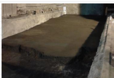
Aplicación de ariblack con cemento de aluminato cálcico para aplicaciones en pavimentos de alta resistencia a la abrasión y temperatura.
