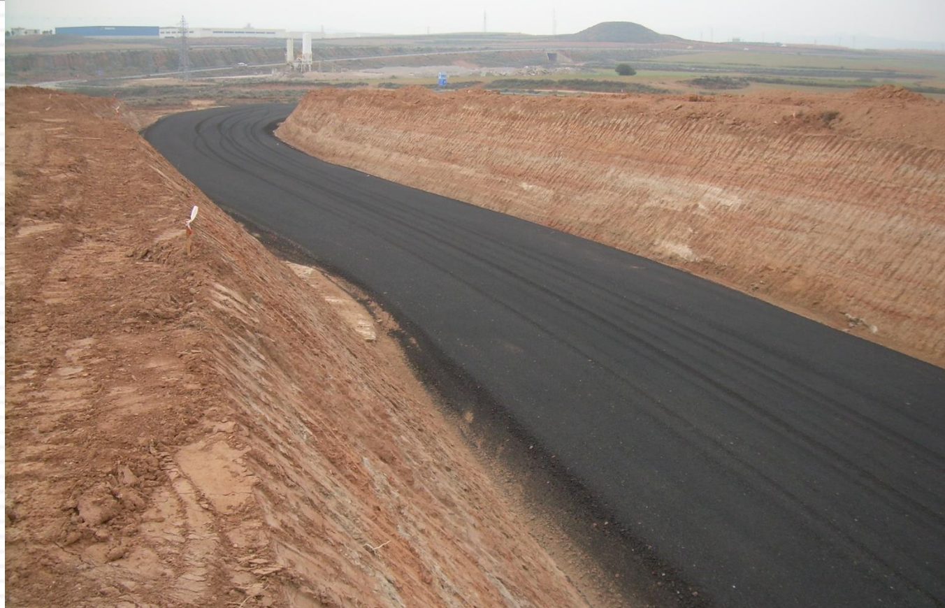
ariblack para aplicaciones en carreteras y viales Subbase Camino Rural Ayuntamiento de Muel
