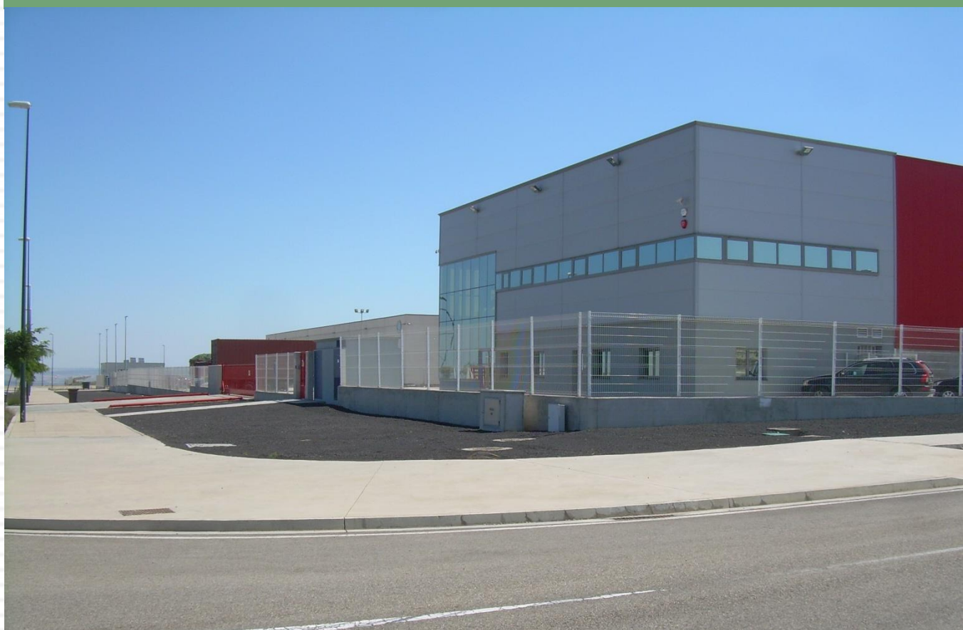
ariblack para usos en jardinería Exterior naves PTR, Zaragoza
