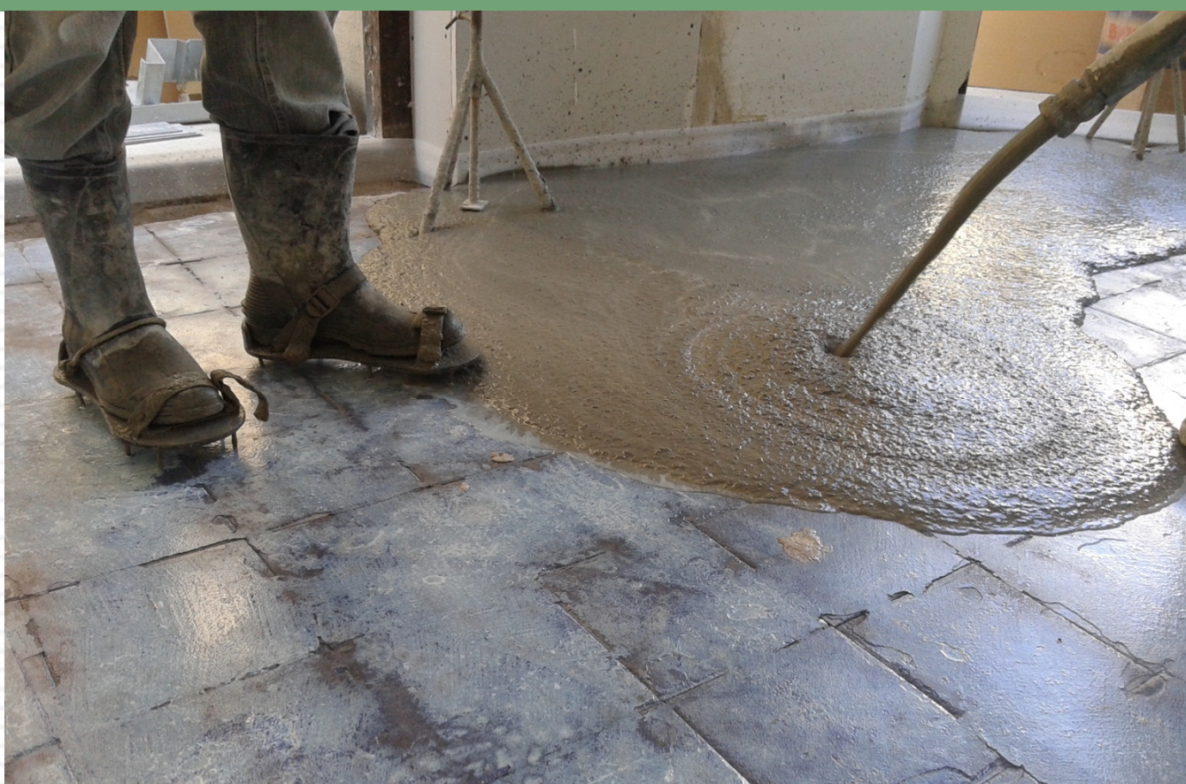
Hotel Suís, Via Laietana, Barcelona. 2016 Bombeo del Prosilence Mix
