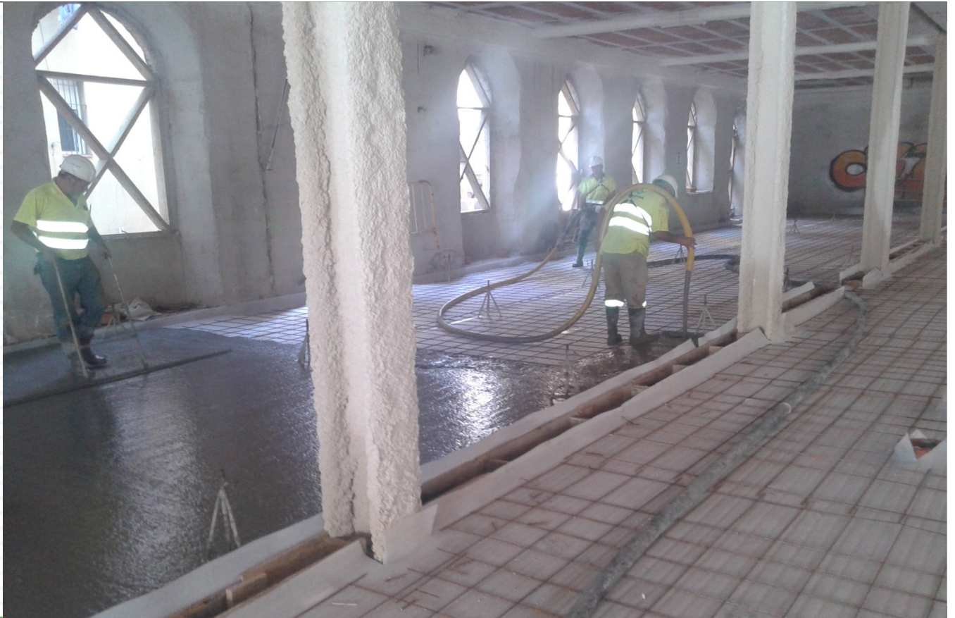
Pavimento Obra Teyco, 2014 Aplicación de mortero Prosilence
