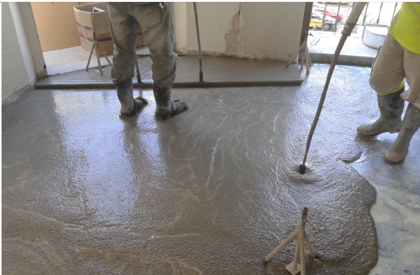
Hotel Suís, Via Laietana, Barcelona, 2016 Aplicación Prosilence Mix mediante bomba estàtica en obra
