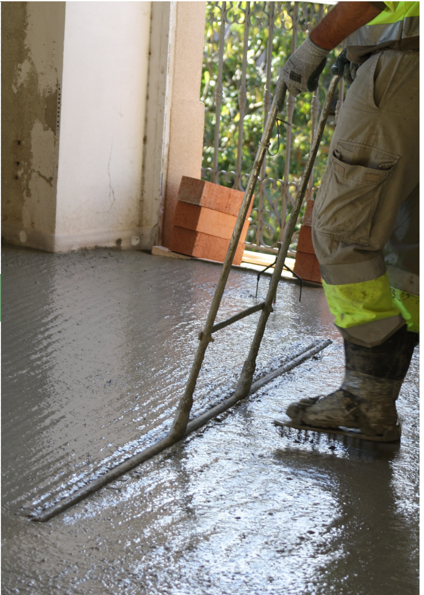
Proceso de desaireado de aire ocluido del Prosilence
