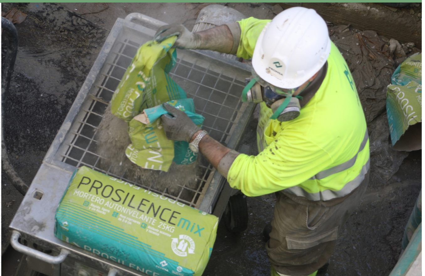
Maquina mezcladora de sacos de Prosilence Aplicación Prosilence Mix mediante bomba estática
