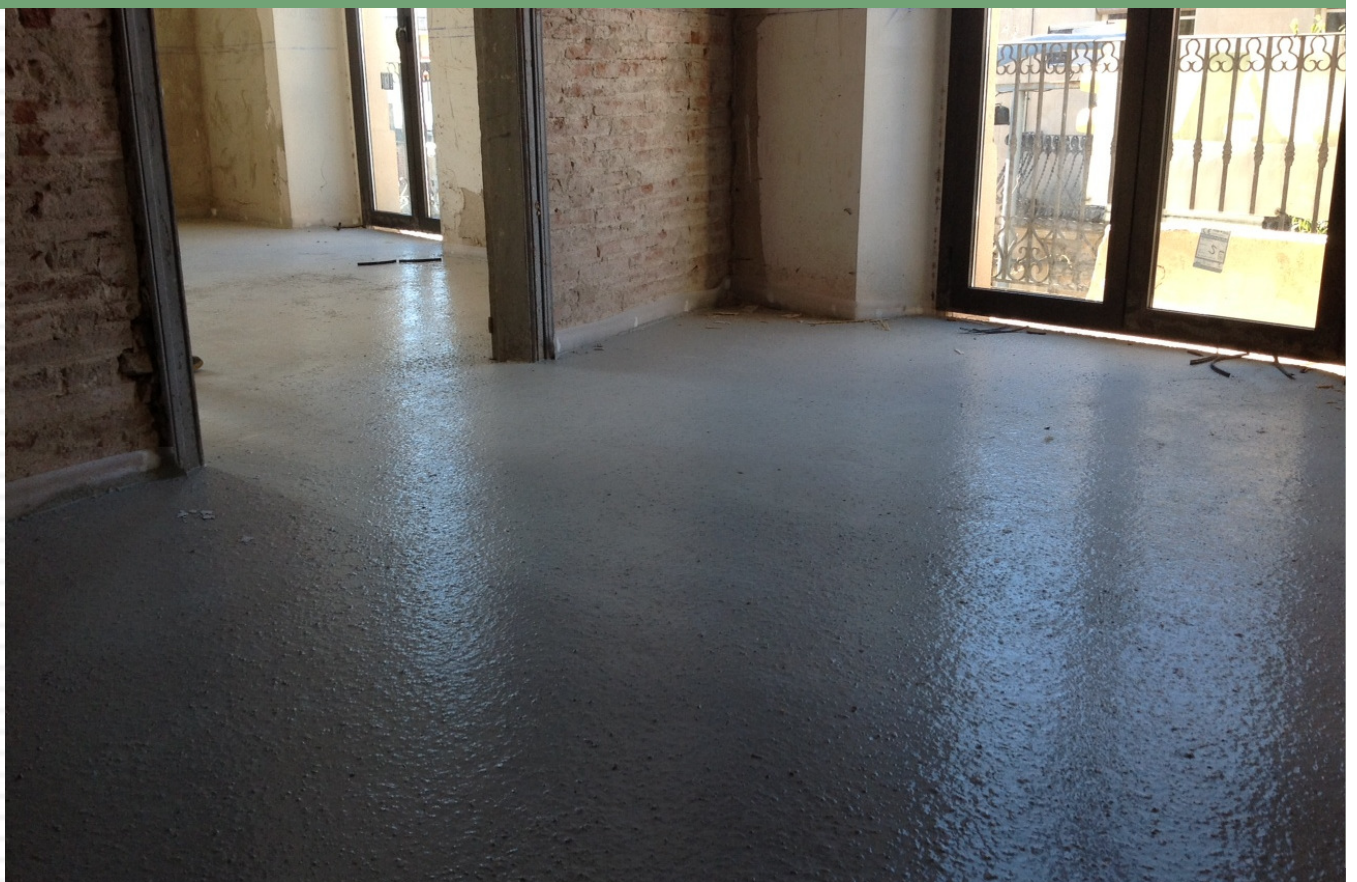
Vista de detalle de la textura del Prosilence Mix seco
