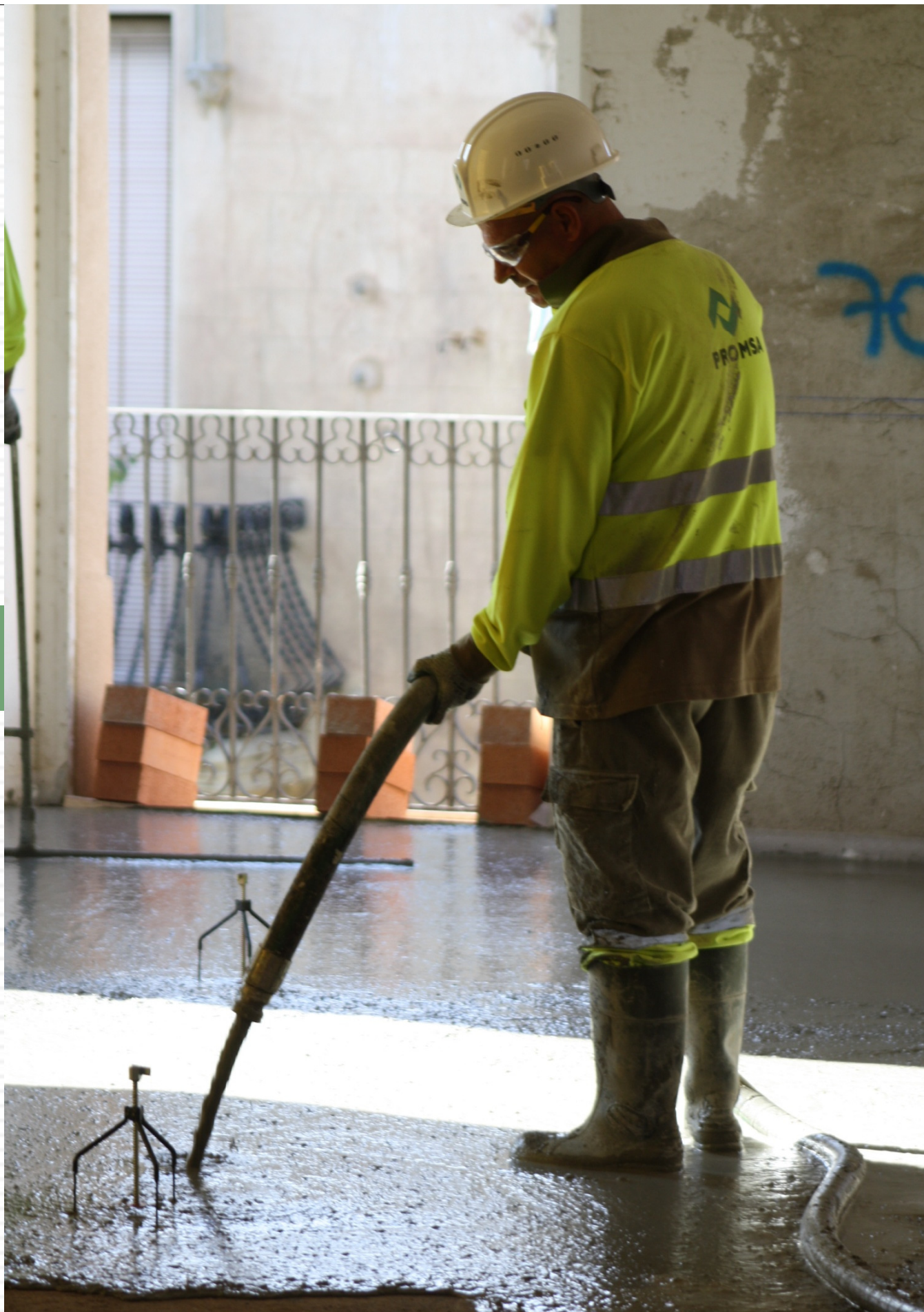
Sistema de aplicación del Prosilence Mix previamente mezclado con la maquina mezcladora de sacos
