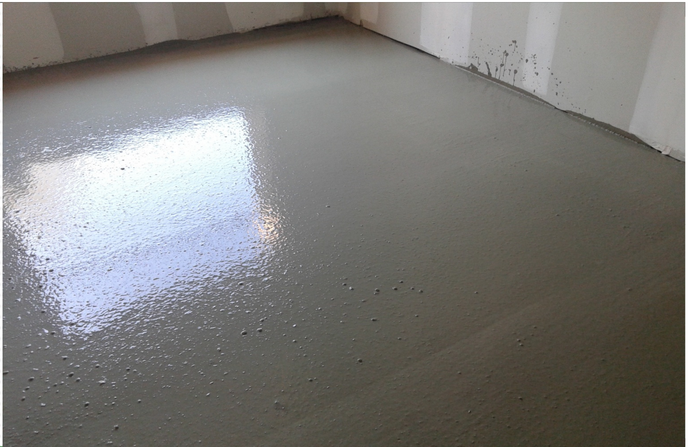
Vista de detalle de Prosilence mix aplicado
