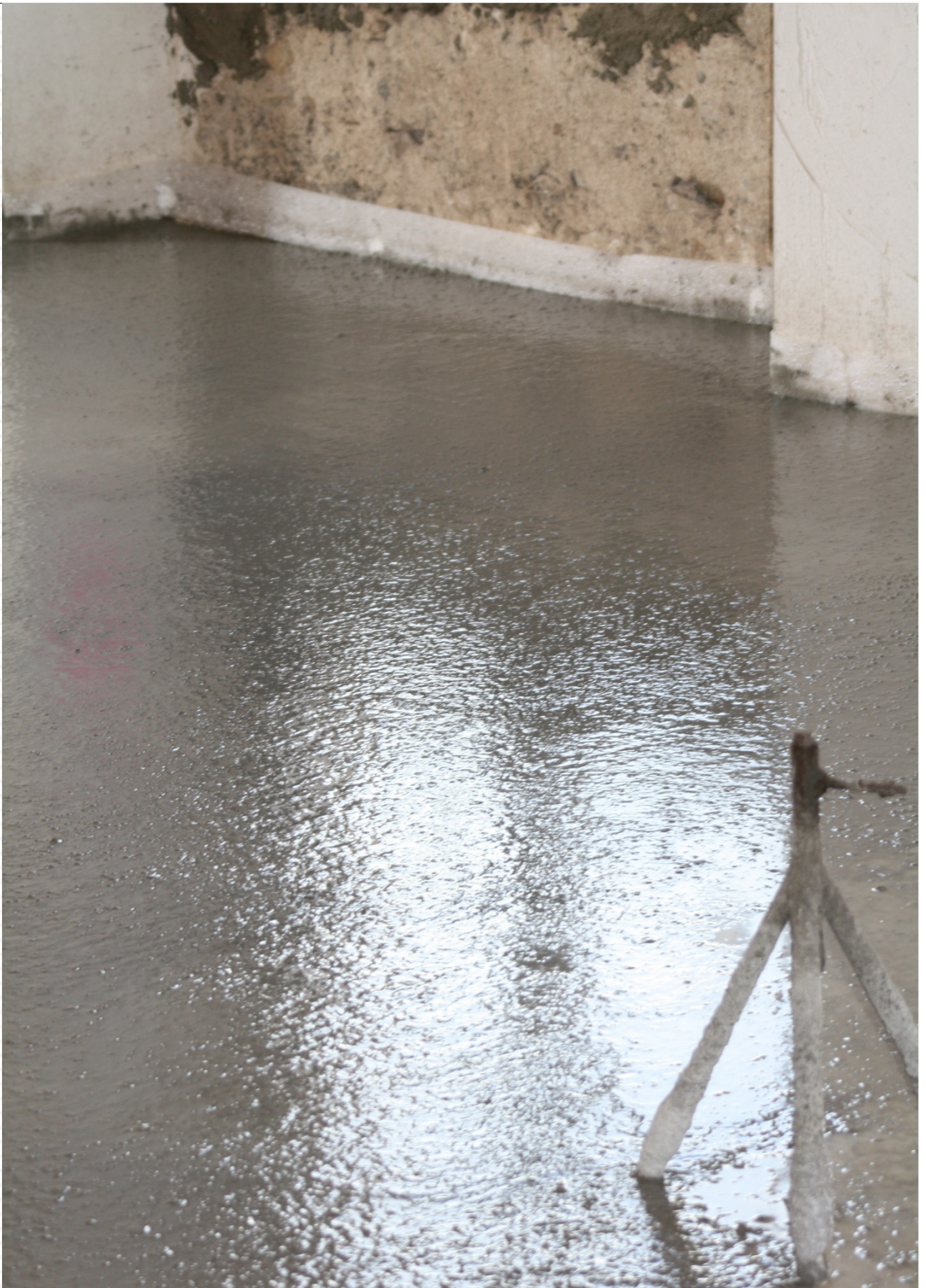
Vista en detalle del Prosilence acabado de aplicar
