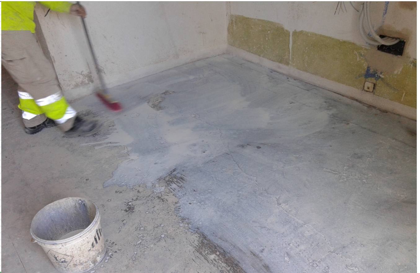
Procedimiento de limpieza de la zona previa a la aplicación de Prosilence
