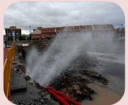
Reparaciones de emergencia en suministros de agua
