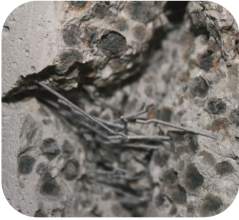
Hormigón con fibras.
