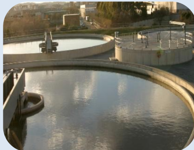
Depuración y tratamiento de aguas
