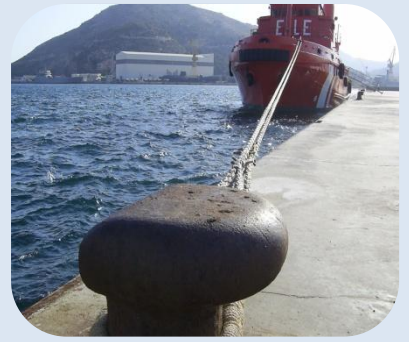
Diques, amarres, zonas portuarias
