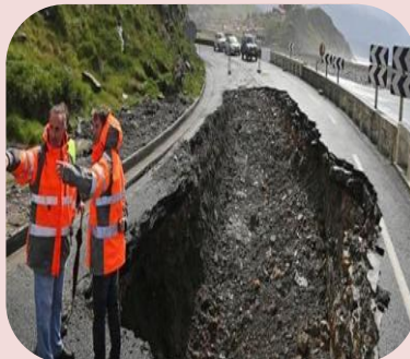
Reparaciones de urgencia en carreteras
