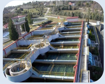
Estructuras para ETAP's
