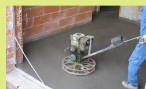
Fresado del PROSILENCE posteriormente a su aplicación.
