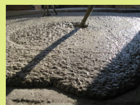
Aplicación de PROSILENCE en obra, mediante uso de bomba y mangueras.
