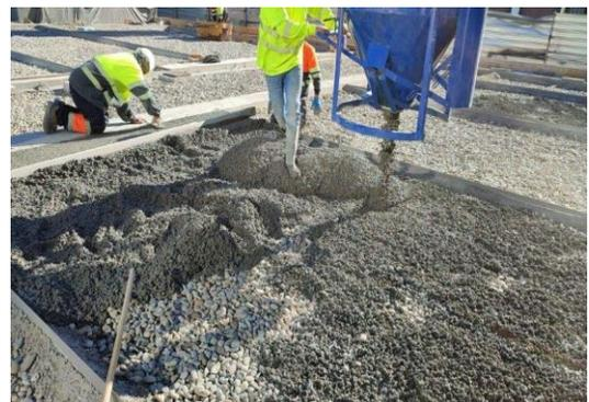
Una nueva formulación de PROMSA, con fibras y aditivos especiales permiten una porosidad del hormigón drenante óptima adecuada para una gestión del agua.
