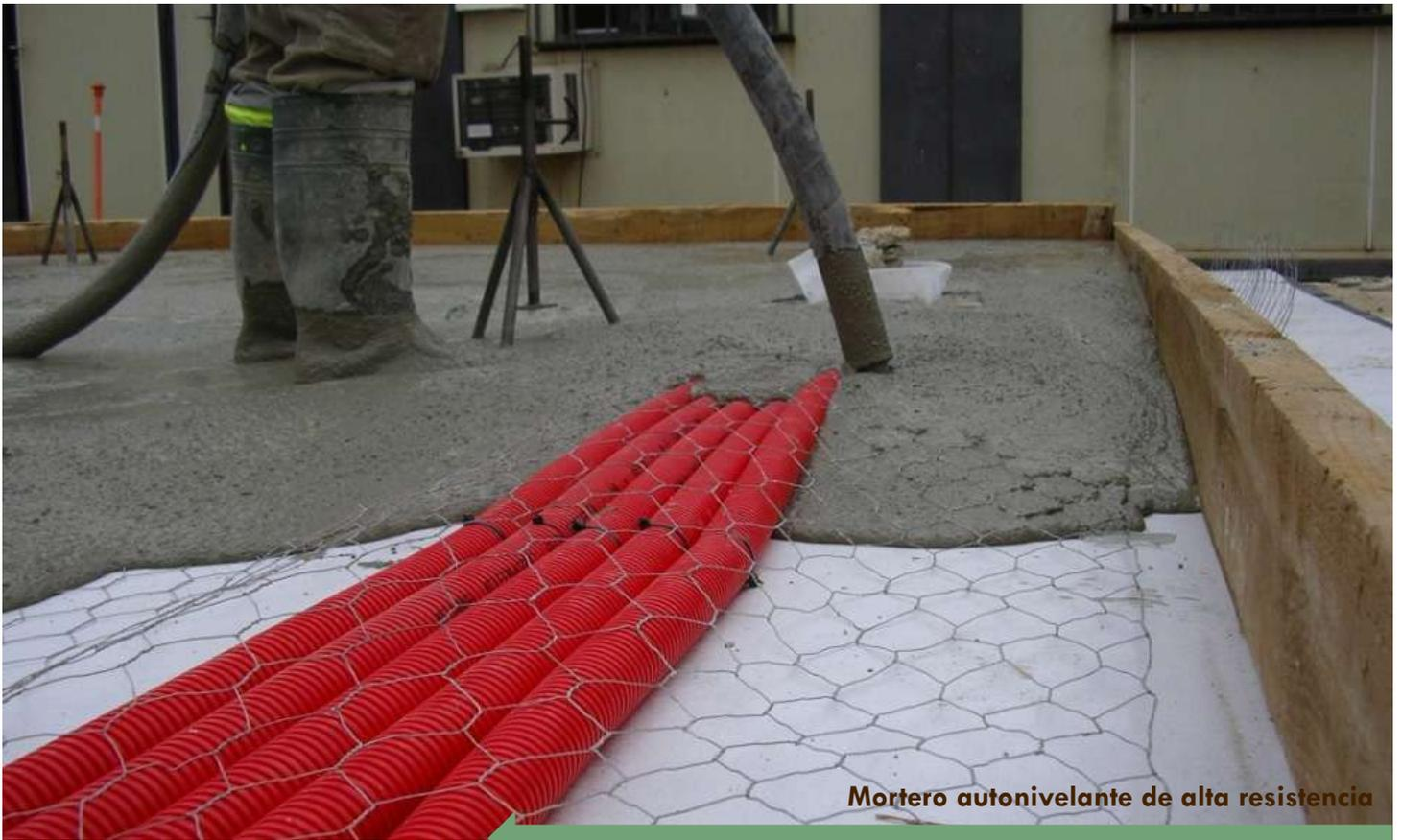
**Mortero autonivelante de alta resistencia**
