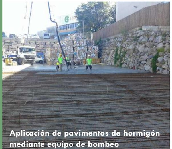
Aplicación de pavimentos de hormigón mediante equipo de bombeo
