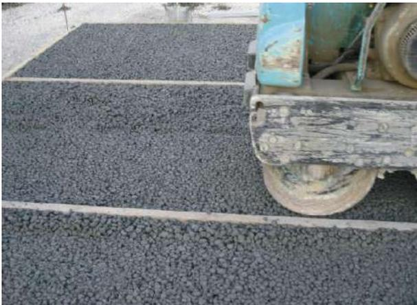
Diferentes tipologías de áridos reciclados que se pueden utilizar en pavimentos drenantes.
