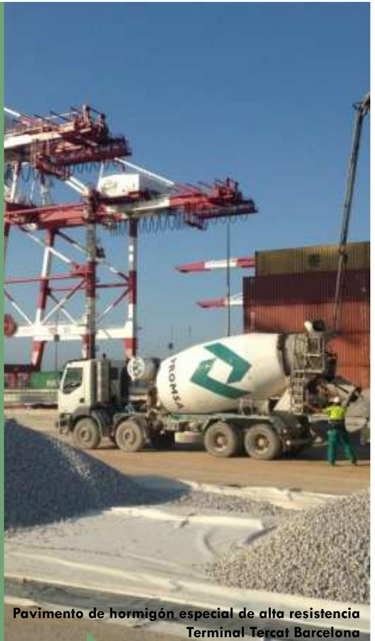
**Pavimento de hormigón especial de alta resistencia
