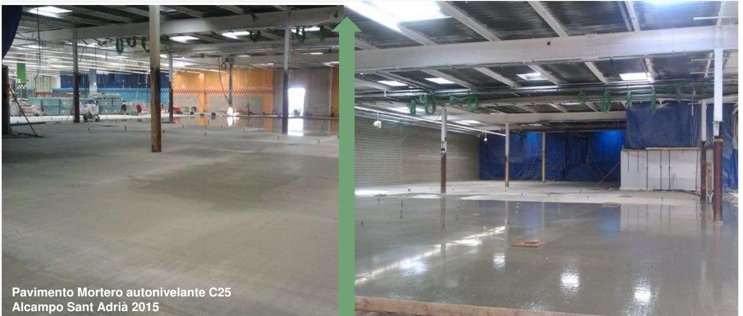
Pavimento Mortero autonivelante C25
