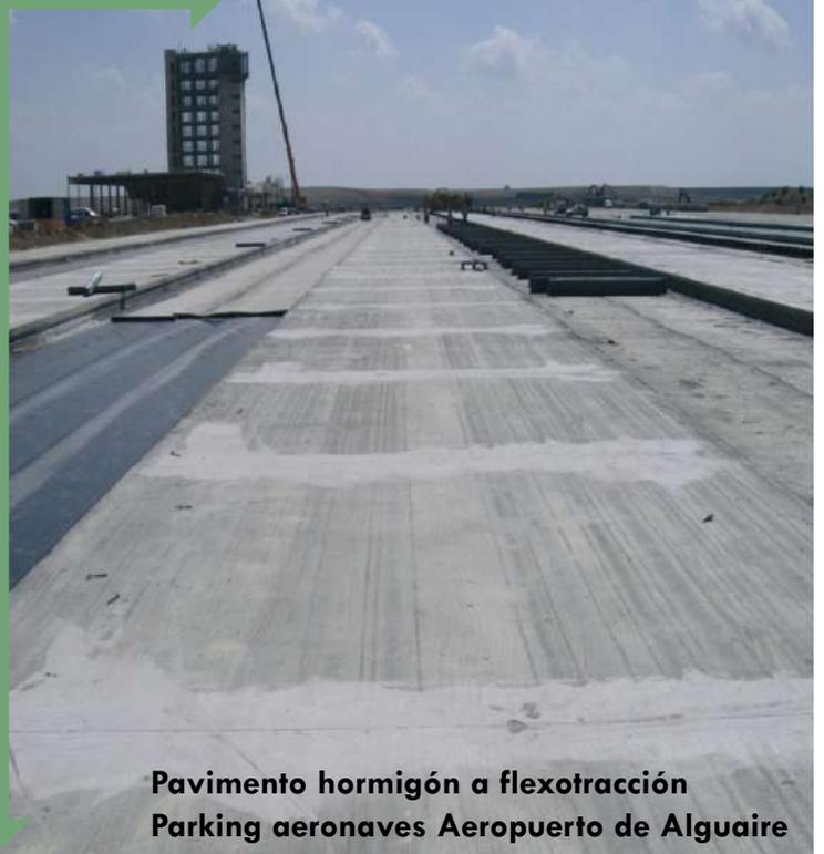
**Pavimento hormigón a flexotracción
