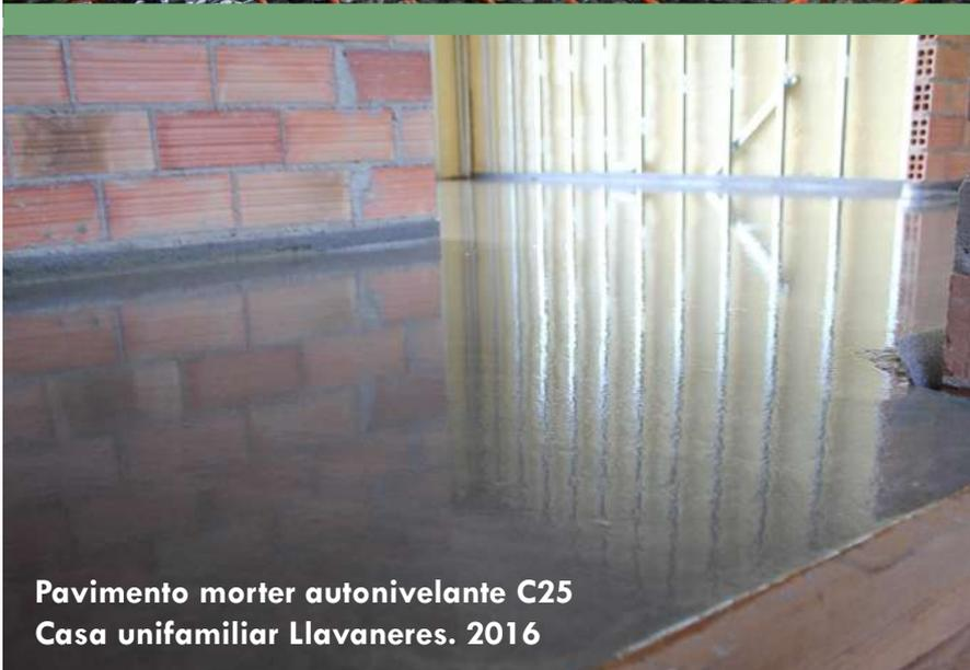
**Pavimento mortar autonivelante C25
