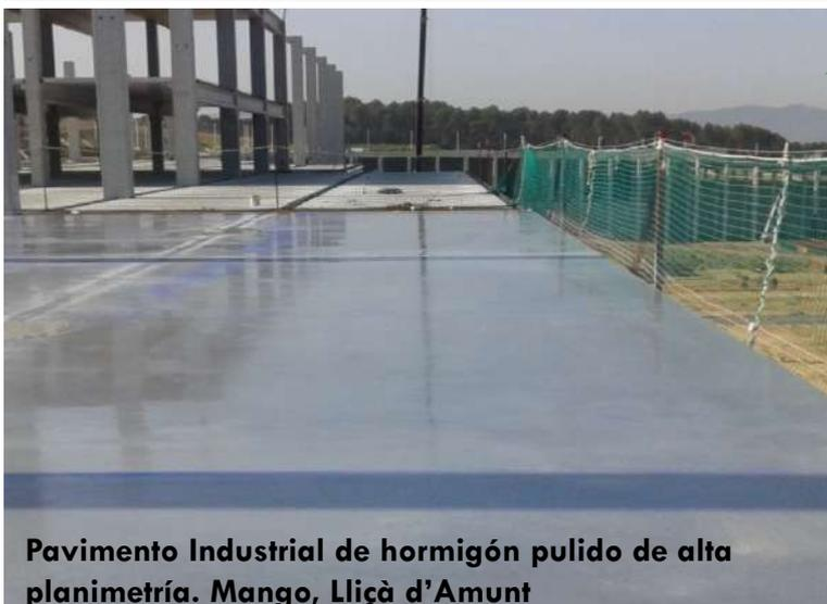
**Pavimento Industrial de hormigón pulido de alta planimetría. Mango, Lliçà d'Amunt**
