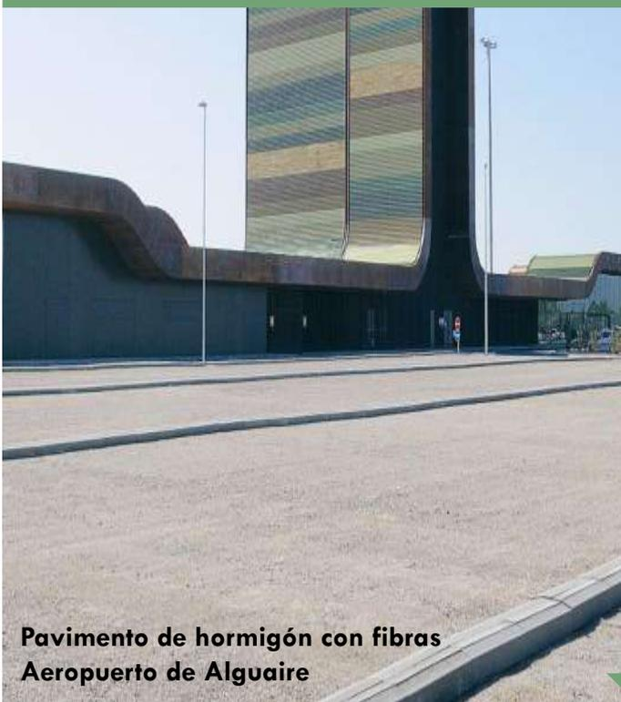
**Pavimento de hormigón con fibras
