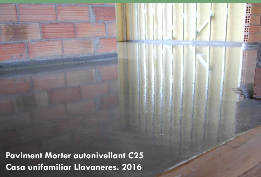
Preparació prèvia a aplicació de Morter Autonivellant C25 Calefacció radiant
