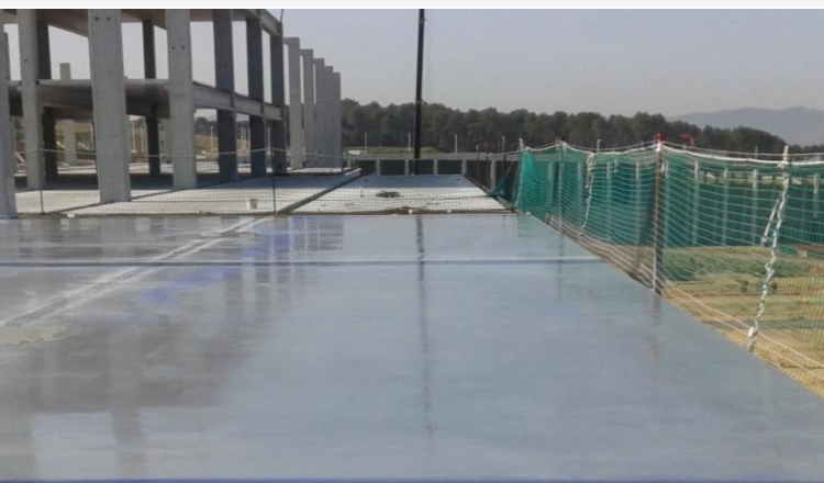
Paviment Industrial formigó pulit d'alta planimetria Mango, Paviment Industrial, Lliçà d'Amunt
