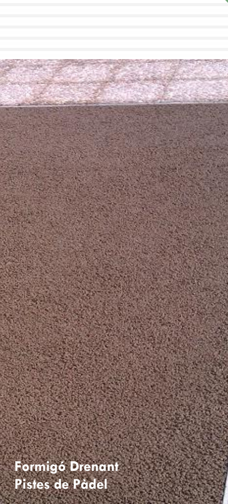
Formigó Drenant Club de Tennis Barcelona, 2016
