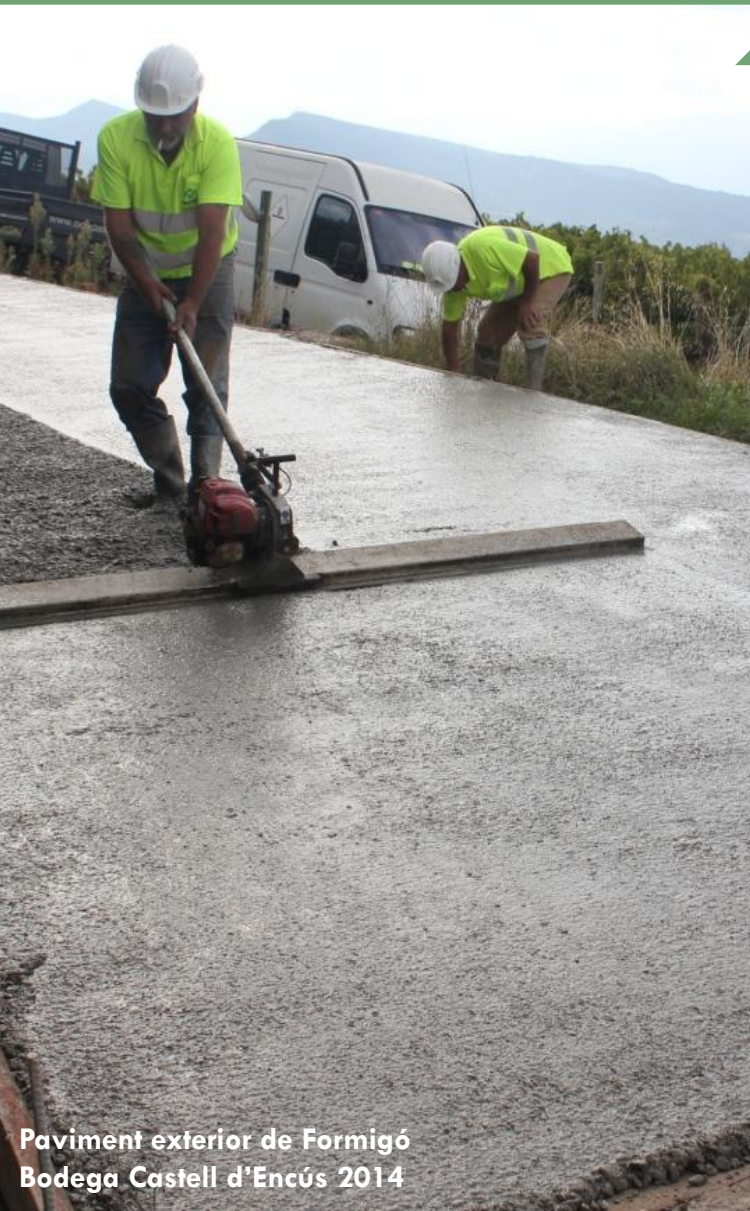
Paviment exterior de Formigó Semifratassat Parc Can Zam, Santa Coloma 2016
