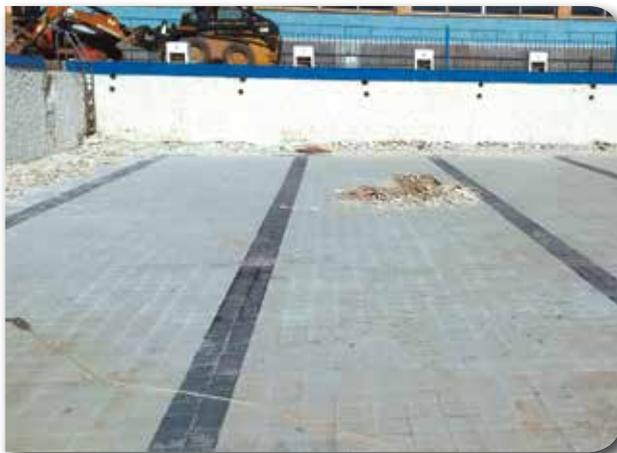
do dos capas cruzadas, dejando secar la primera capa de mortero unas 6 horas antes de la aplicación de la segunda. Aplicar **BETOFIBER GLASS** mientras esta primera capa está fresca. El espesor mínimo total de la membrana para que cumpla su función (sumando las dos capas), debe ser de 2 mm. El consumo de **PROPAM® IMPE FLEX** y **FLEXITEC** es de 1,5 Kg/m<sup>2</sup> por capa.
