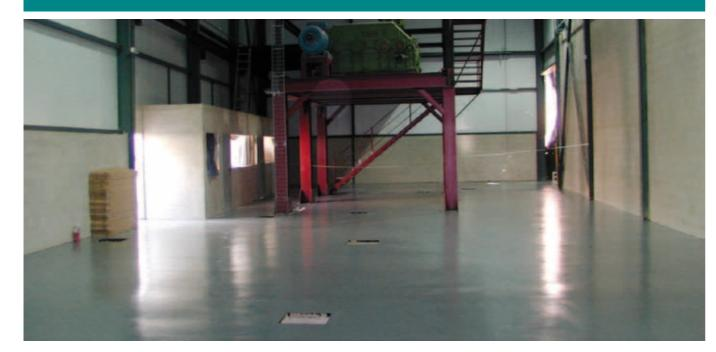
Diseñado para la ejecución de pavimentos sometidos a muy altas cargas, consiste en la preparación de un mortero con alta carga de árido en relaciones entre 1:5 y 1:8, para su aplicación en espesores habituales entre 5 y 10 mm. De acabado ligeramente rugoso es posible su sellado con resinas transparentes o coloreadas.
