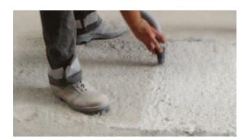
El aspecto más importante a considerar a la hora de ejecutar un pavimento, es sin duda, la preparación que ha de realizarse sobre el soporte. Un correcto tratamiento y preparación del soporte es clave para garantizar un buen desempeño y durabilidad del pavimento ejecutado.
