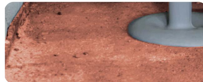
**4** Aplicar el mortero una vez esté seca al tacto (entre 30 y 90 minutos), según temperatura ambiente. En soportes no porosos, dejar secar completamente (entre 1 y 3 horas), según temperatura ambiente.
