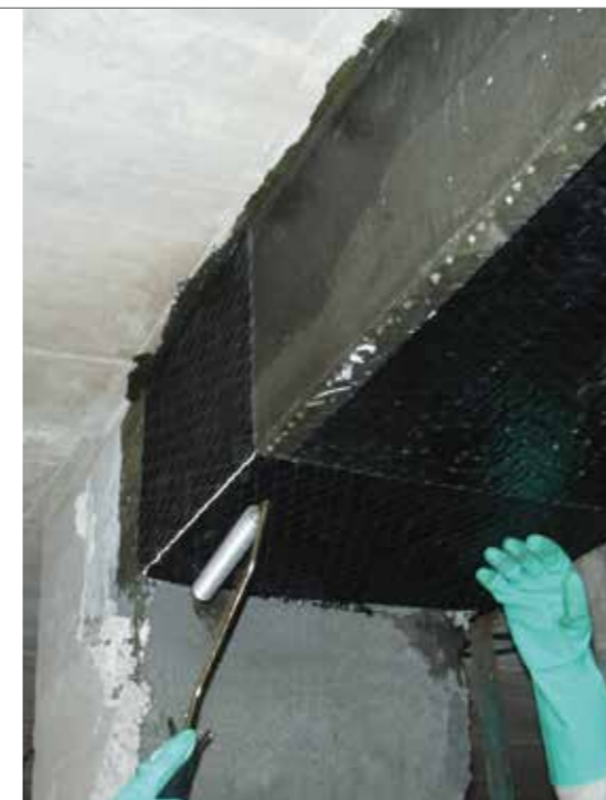
Refuerzo de vigas a cortante. PROPAM® CARBOCOMP TEXTIL
