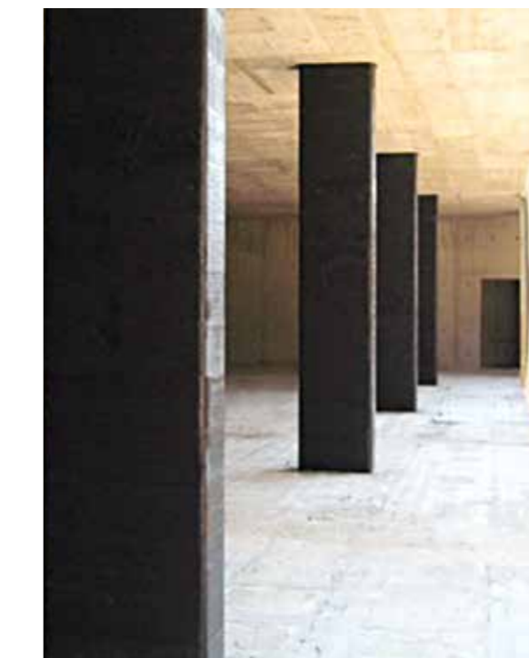
Refuerzo de pilares a confinamiento PROPAM® CARBOCOMP TEXTIL
