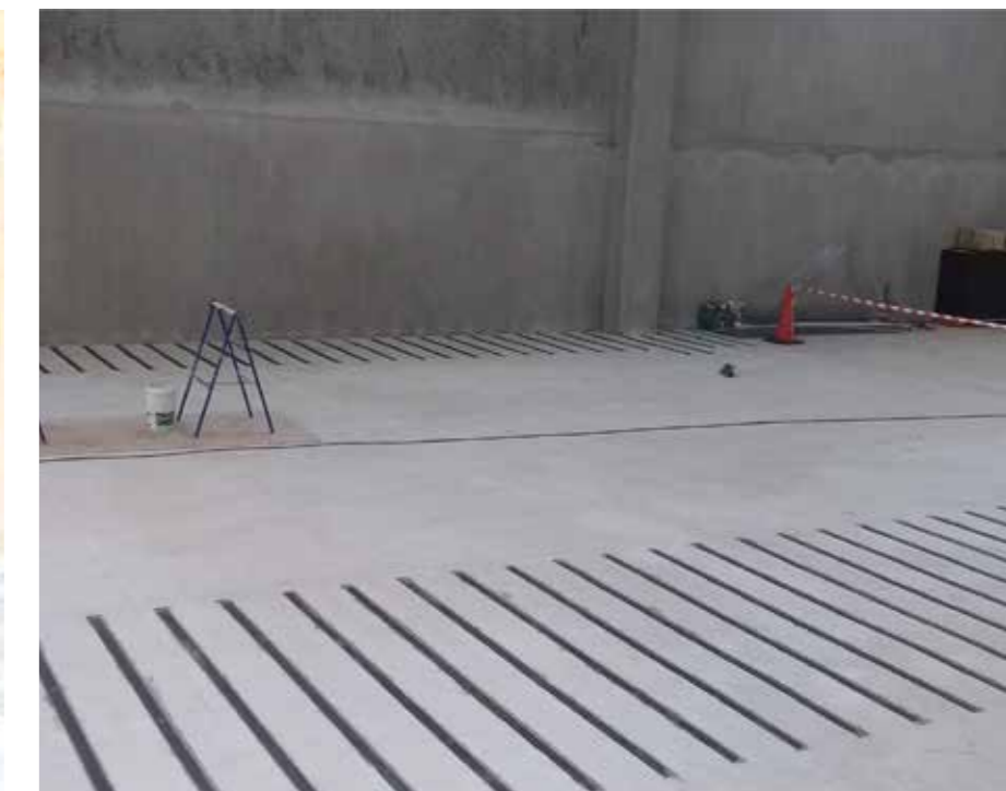
Refuerzo de forjado a flexión. PROPAM® CARBOCOMP
