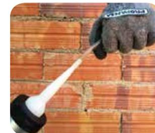
**6** Para facilitar la ejecución, insertar cánula flexible en la punta de la boquilla.
