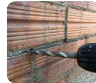
**2** Realizar orificios de 12 mm de diámetro, en horizontal en el plano coincidente con la junta.
