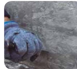
**1** Retirar el rodapié cerámico o de madera, y eliminar el yeso o mortero degradado hasta llegar al soporte original.
