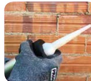
**5** Colocar boquilla y enroscar al tubo. Los dos elementos punzantes de la boquilla perforarán el salchichón permitiendo la salida de **PROPAM® CREAM**.
