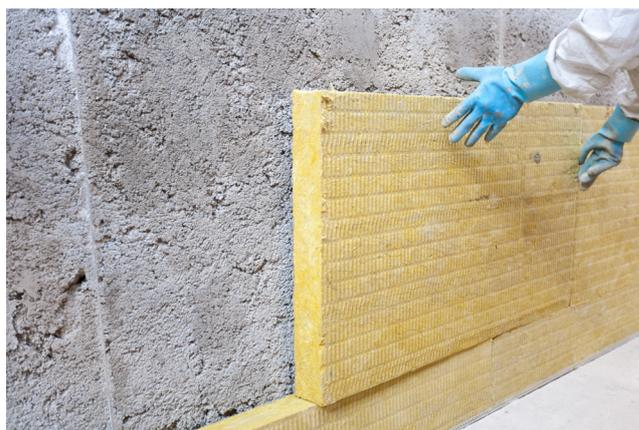
Figura 2. Colocación del SATE
