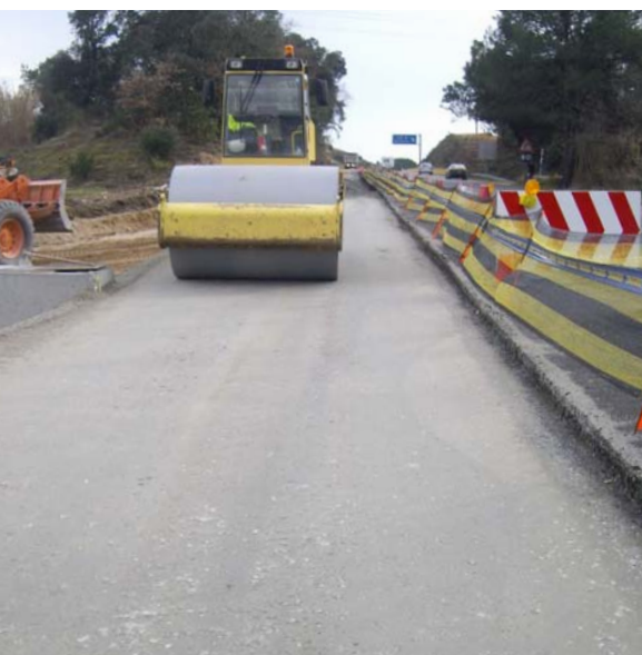
SUELO CEMENTO Granulometría de los áridos SC40, SC20 Contenido mínimo de cemento: 3% Índice de plasticidad < 15
