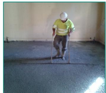
HAL es el hormigón autocompactante y ligero con capacidad de ser bombeado, aporta una gran resistencia aligerando el conjunto estructural.
