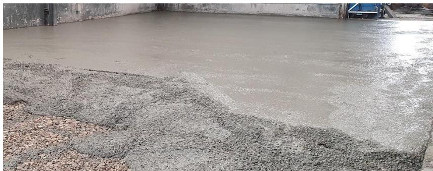
Con PROLIMIT se minimizan las juntas y los cortes en el pavimento. Su formulación utilizando fibras poliméricas estructurales permite evitar el uso de armaduras, creando superficies continuas y estéticas de altas prestaciones de hasta 150m<sup>2</sup>.
