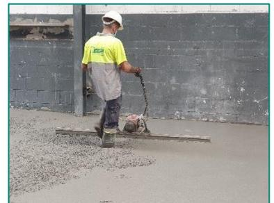
PROLIMIT es un hormigón de altas prestaciones sin límites que tiene en su composición fibras estructurales, de acuerdo con el anexo 7 del Code “Recomendaciones por el uso del hormigón con fibras” Este hormigón consigue resistencias características a compresión y residual a flexotracción sin tener que hacer uso de armado simple o doble y pudiendo alcanzar amplias superficies minimizando las juntas y cortes en el pavimento.
