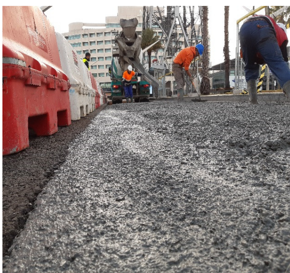
Aplicación HRR a obra
