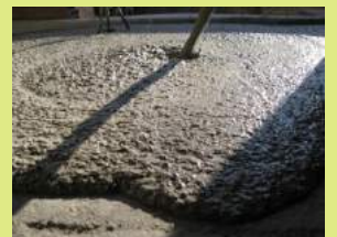
Aplicación de PROSILENCE en obra, mediante uso de bomba y mangueras.
