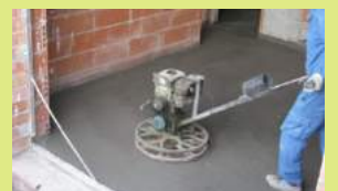
Fresado del PROSILENCE posteriormente a su aplicación.
