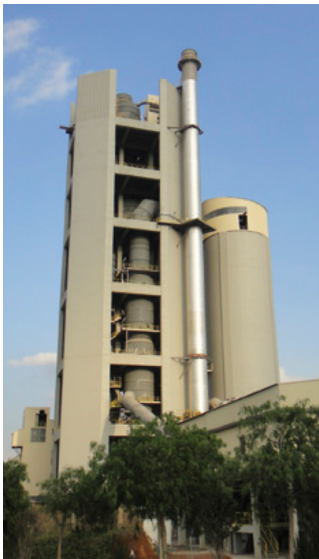
> Sant Vicenç dels Horts plant, Barcelona, Spain
