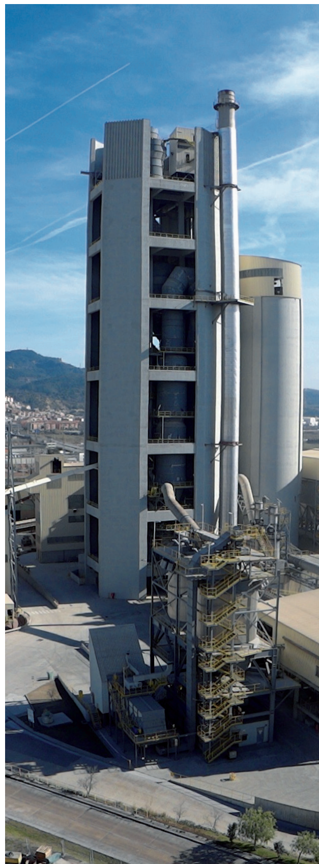
> Sant Vicenç dels Horts plant, Cementos Molins Industrial
