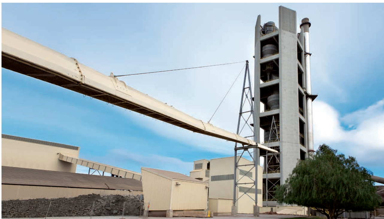
> Sant Vicenç dels Horts plant, Cementos Molins Industrial.
