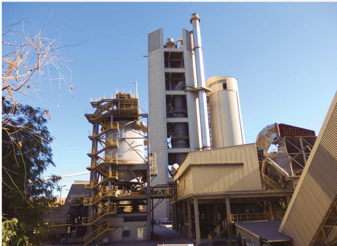
► Sant Vicenç dels Horts plant, Cementos Molins Industrial
