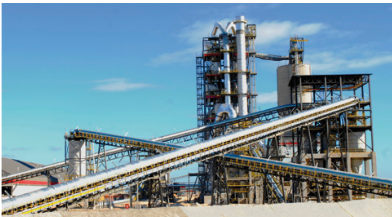
> Fábrica de Kairouan, Túnez
