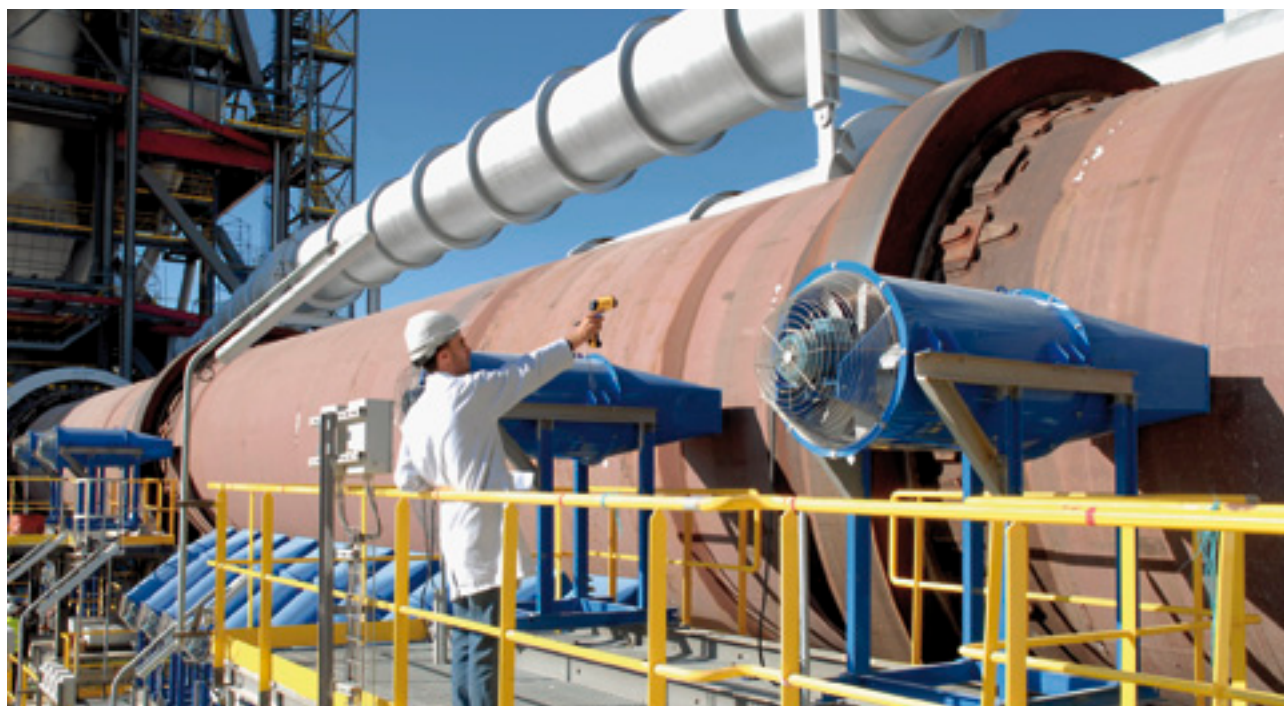
> Fábrica de Kairouan, Túnez
