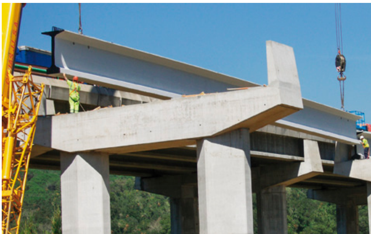
> Instalación de una estructura prefabricada, Precon
