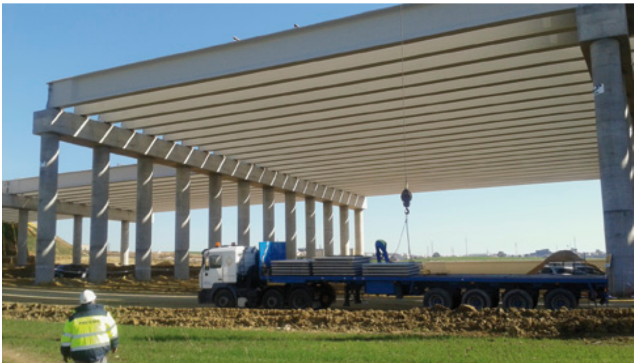
> Instalación de una estructura prefabricada, Precon
