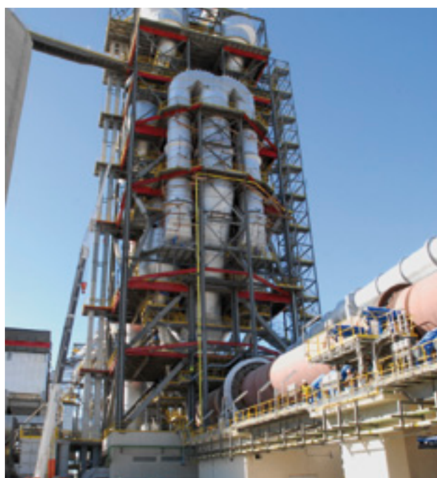
> Fábrica de Kairouan, Túnez
