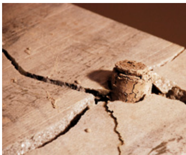
> Detalle de la aplicación de "Betonamit", mortero expansivo sin detonación, producto de Propamsa
