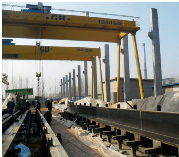
> Obras de construcción de la nueva fábrica de Precon China
