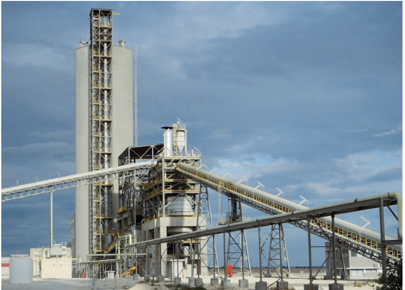
> Fábrica de Kairouan, Túnez
