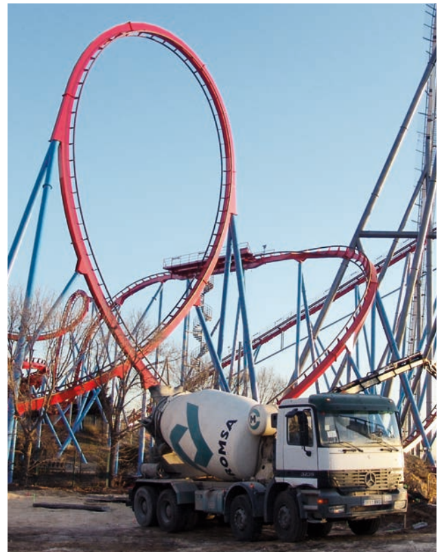
> Suministro de hormigón, Promsa
