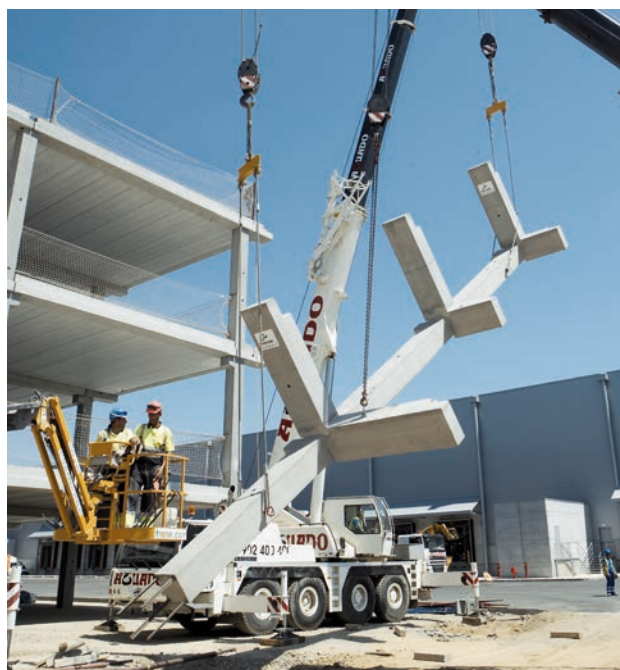
> Maniobra de elevación de pilar, Precon
