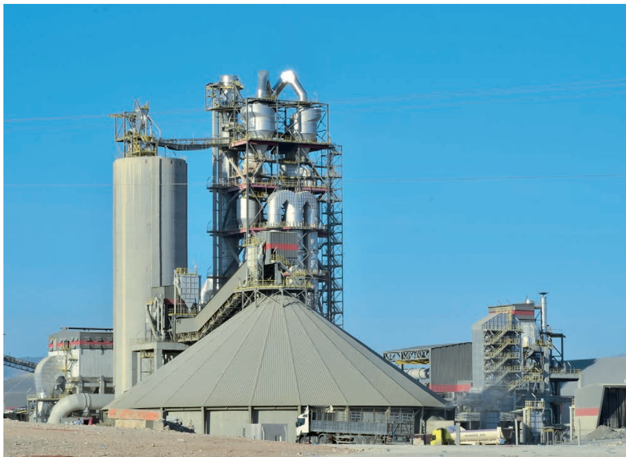
> Fábrica de Kairouan, Túnez
