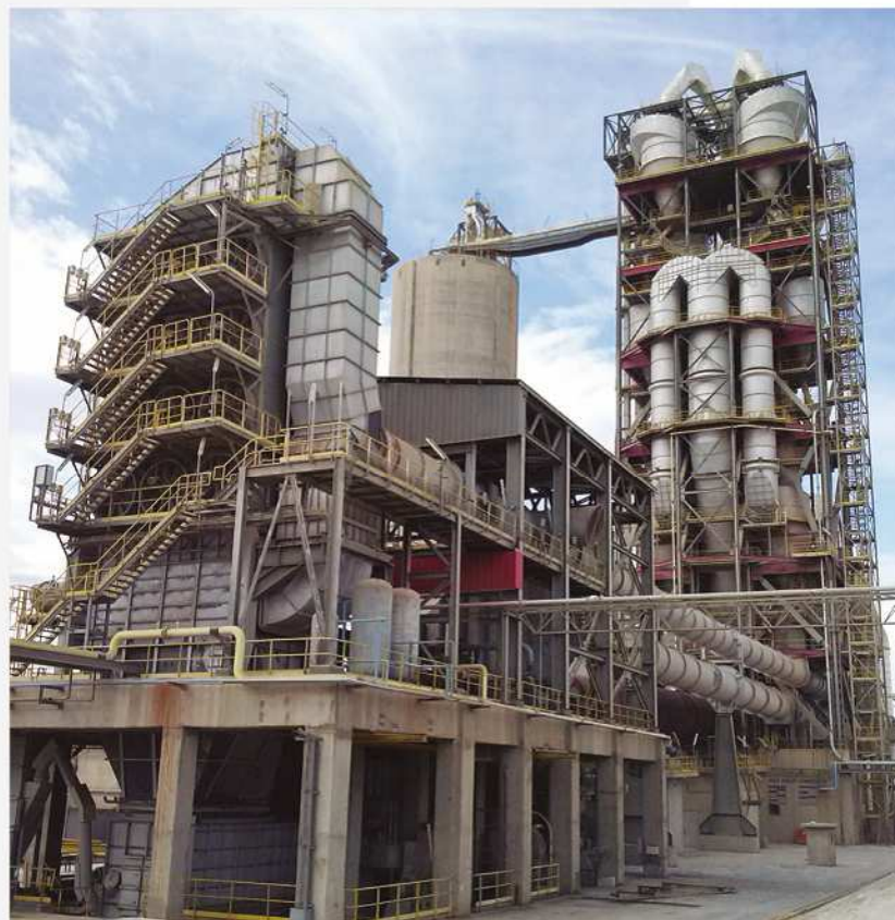
► Fábrica de Kairouan, Túnez.
