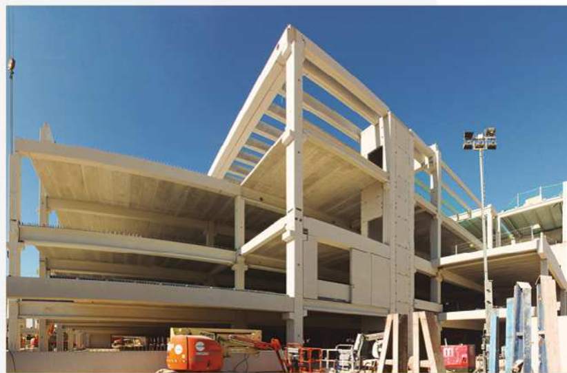
► Estructura prefabricada de gran superficie. Precon. España.
