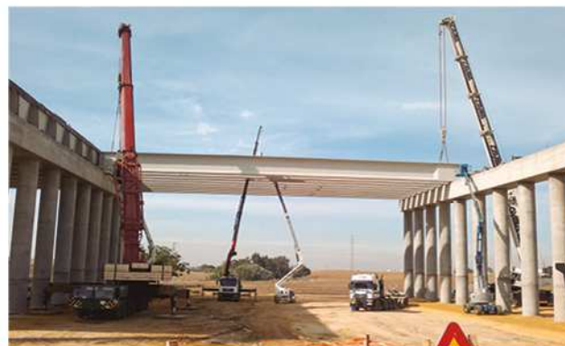
► Montaje de estructuras doble T. Precon. España.
