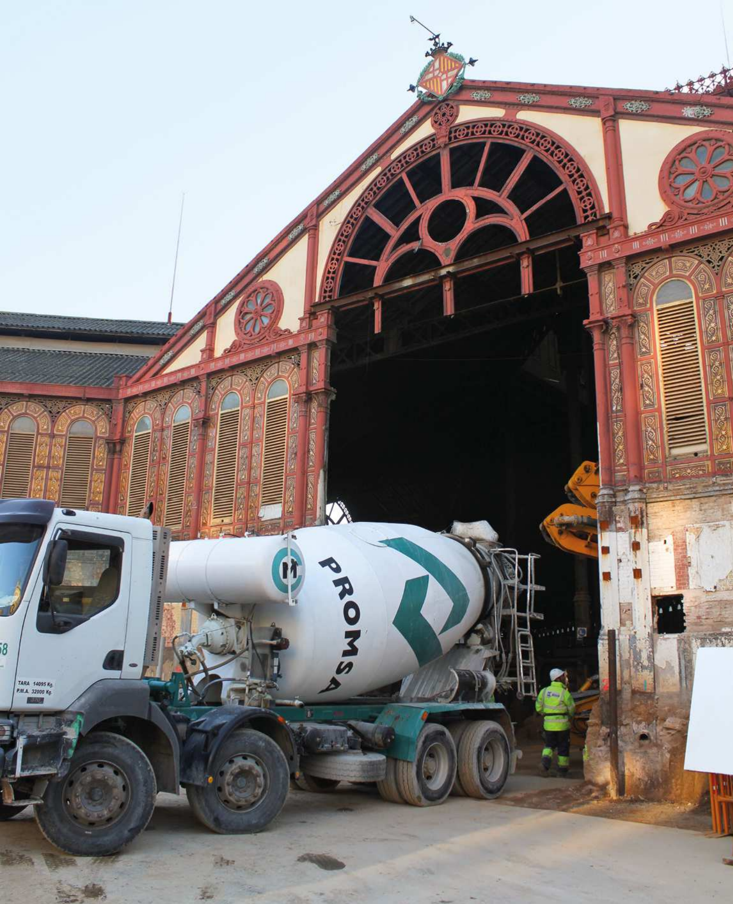
► Suministro de hormigón. Promsa, España.
