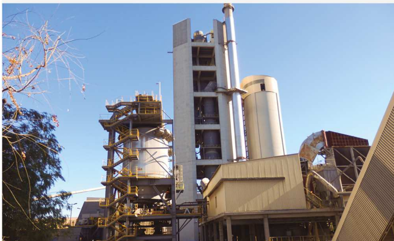
► Fábrica de Sant Vicenç dels Horts, Barcelona. Cementos Molins Industrial.
