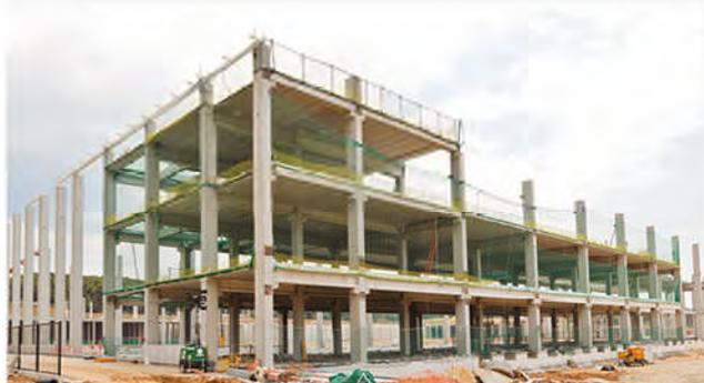
> Estructura prefabricada para gran superficie, España. (Precon)
