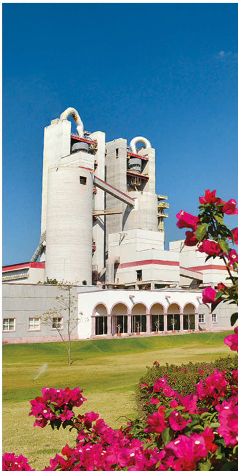
> Cerritos plant, Mexico.
