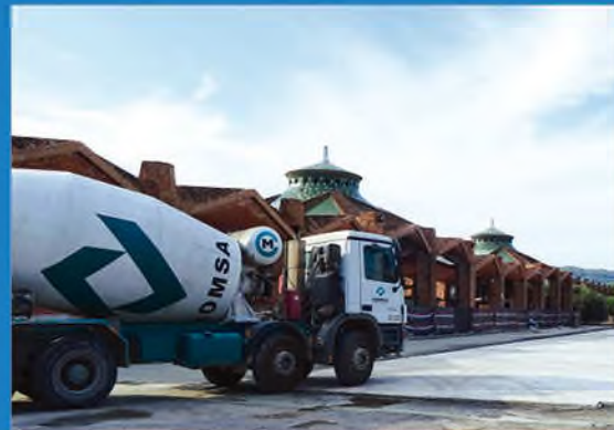
Suministro de hormigón. Promsa.
